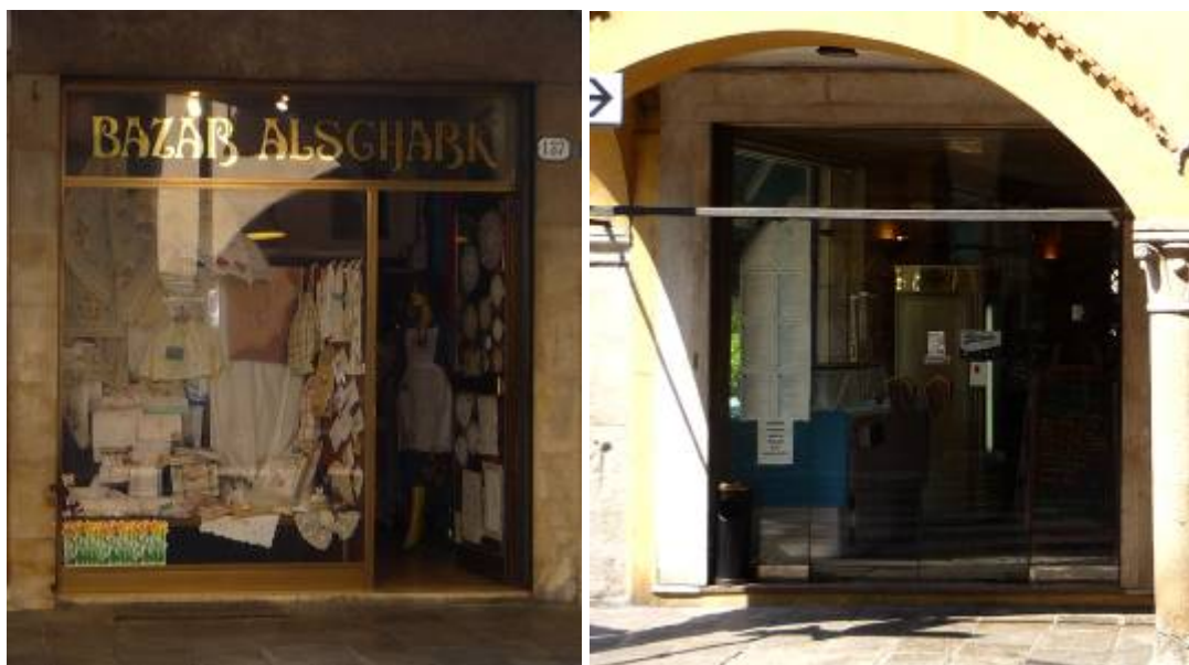
Alcuni esempi di ingressi che necessitano riqualificazione su Via del Santo.
