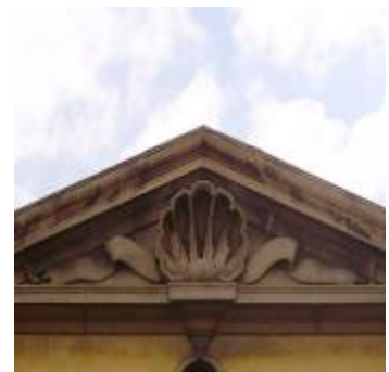
Timpano dell'abitazione di Ernesto Belmondo - civ. 20
